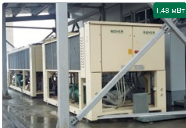
ЗАВОД «РОЛЛ АГРО», ДЗЕРЖИНСК чиллеры воздушного охлаждения с винтовым компрессором
