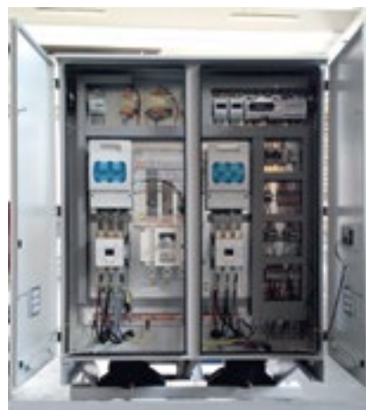
Электрический шкаф исполнения IP54
